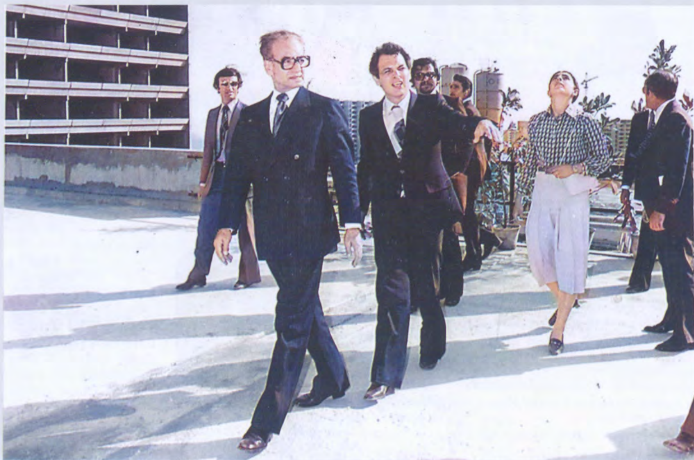
Lo Scià di Persia sul cantiere di Secondo Polo. Sullo sfondo si vedono i silos di cemento ed operai al lavoro
