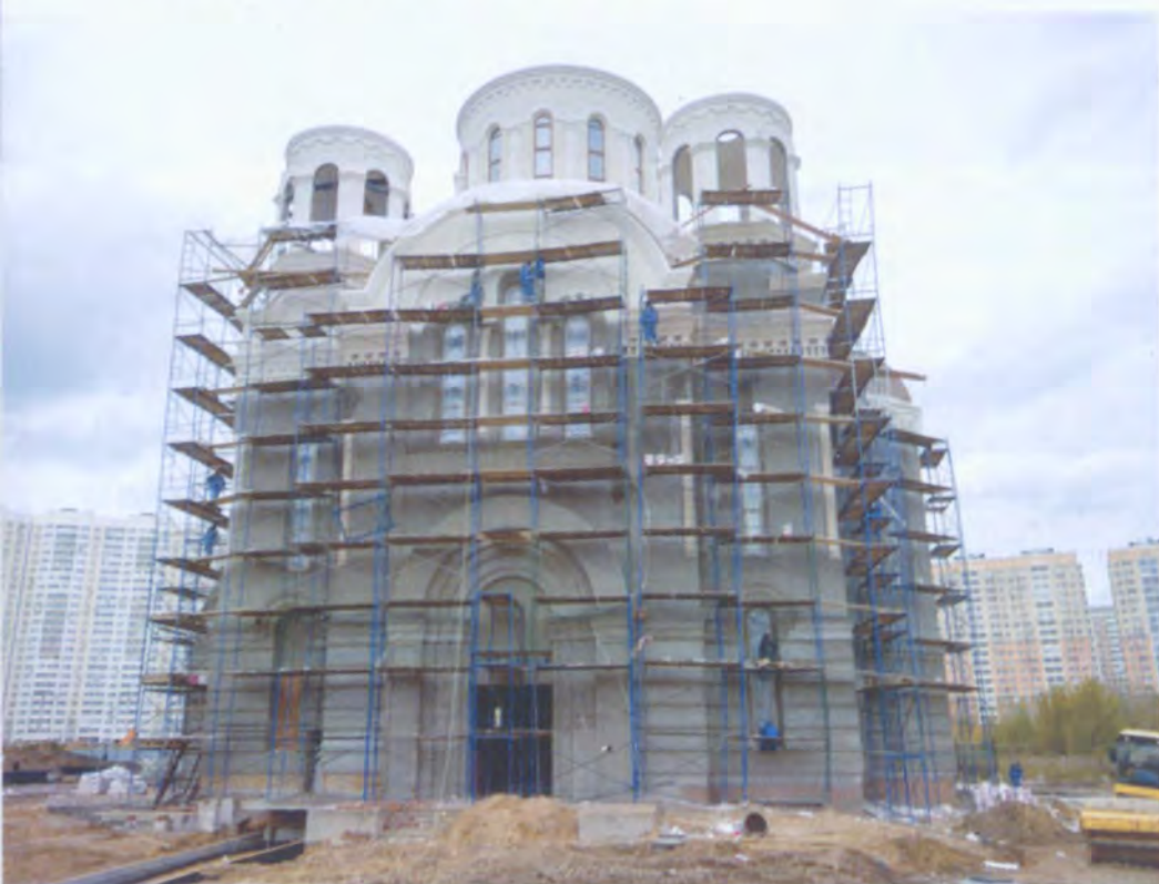
Una chiesa ortodossa in costruzione a Mosca
