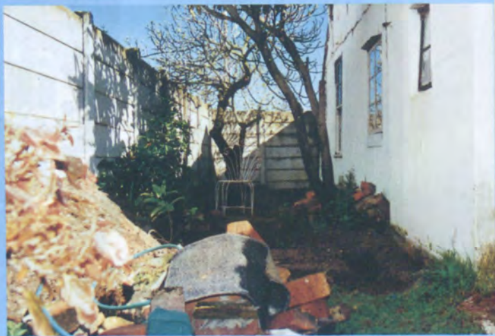
Particolare dei futuri servizi
