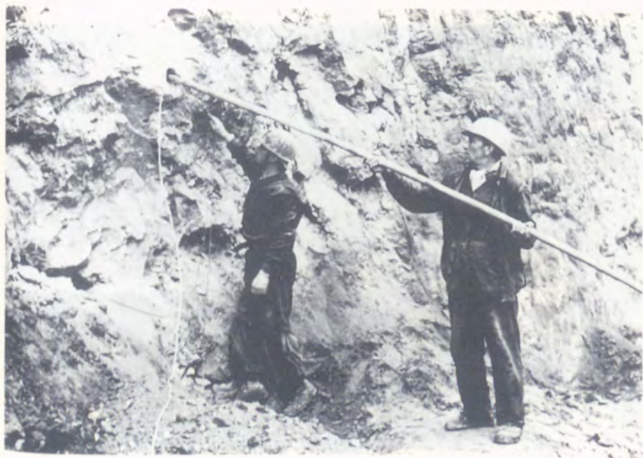
Posa dell'esplosivo (Emanuel Foyo, Domenico Pilot)
