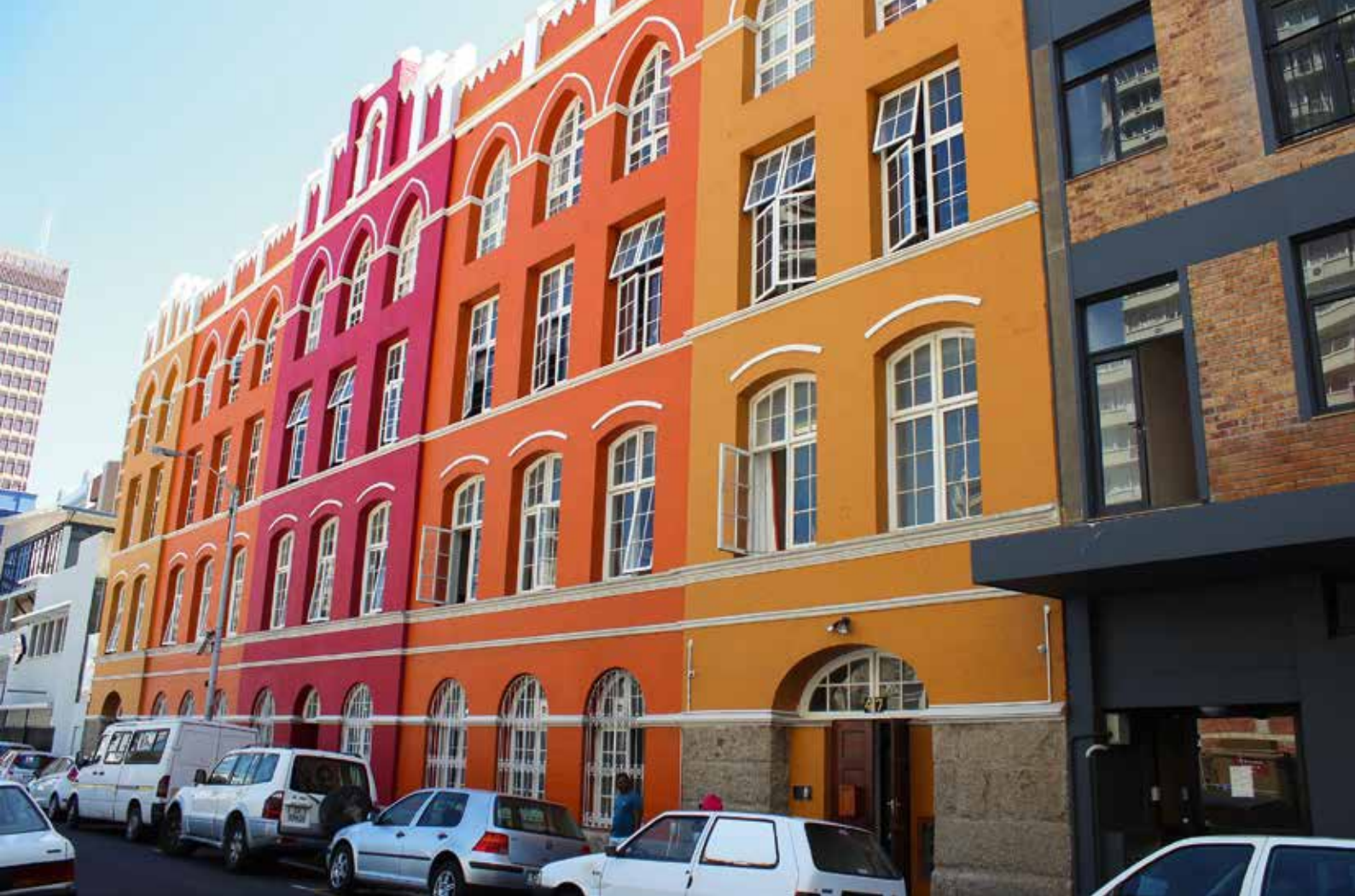
| Edificio di SCCT e SIHMA, Cape Town, Sud Africa
