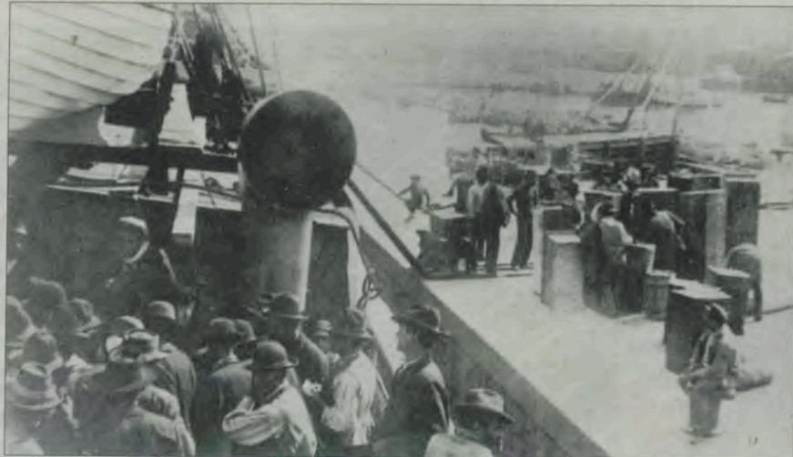
Sul ponte di III classe (1909)
