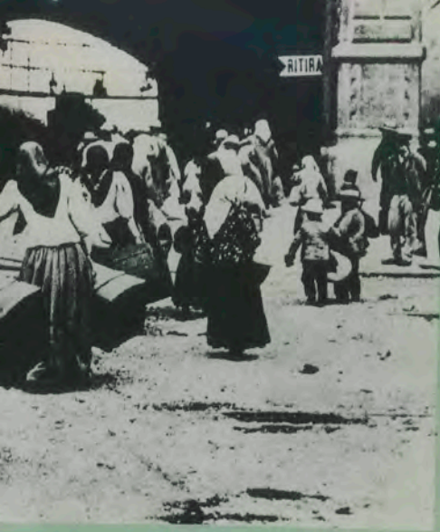
Emigrati in partenza dalla stazione di Milano (1889) e (a sinistra) dipinto "La stazione Centrale di Milano" di Angelo Morbidelli (1889). Sotto: l'esterno della stazione agli inizi del secolo.
