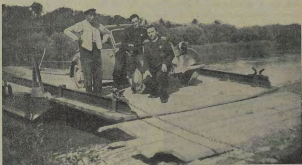
SUL RENO: Due Missionari Scalabriniani in visita agli operai italiani in Germania attraversano il fiume su un ponte mobile.
