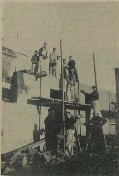
Saens Peña: La cappella italiana in costruzione.
