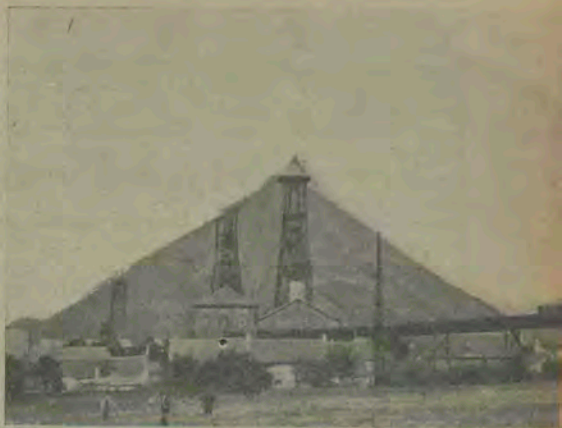
Uno dei tanti « terrills », formato con terra e materiali residuanti estratti dalle miniere di carbone
