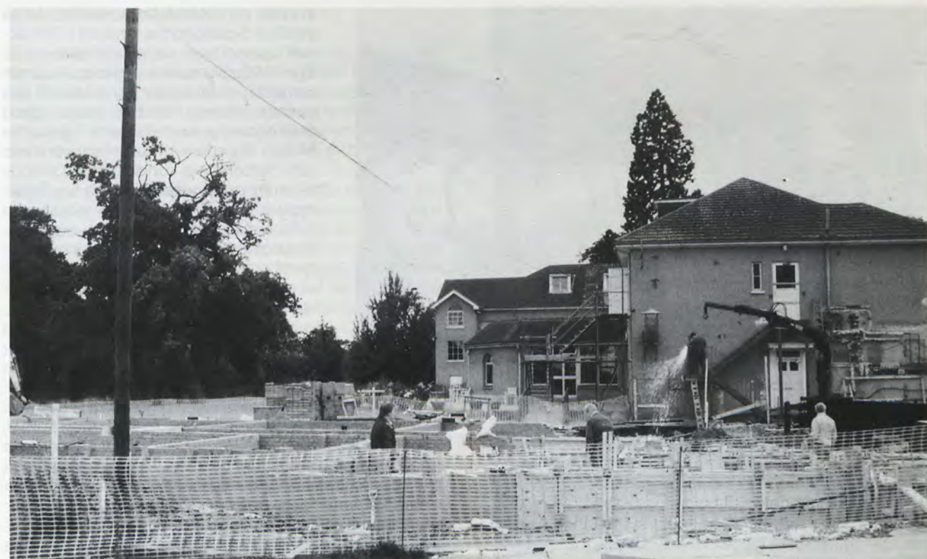
Shenley: Villa Scalabrini. Lavori di ampliamento
