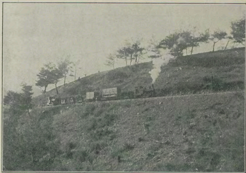
La piccola ferrovia a servizio della linea in costruzione.
