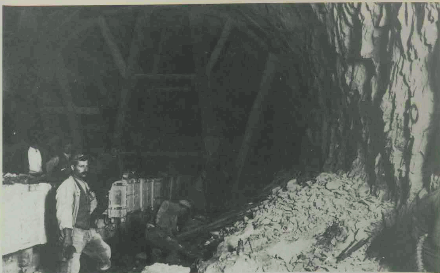
Sistemi di lavoro in galleria
