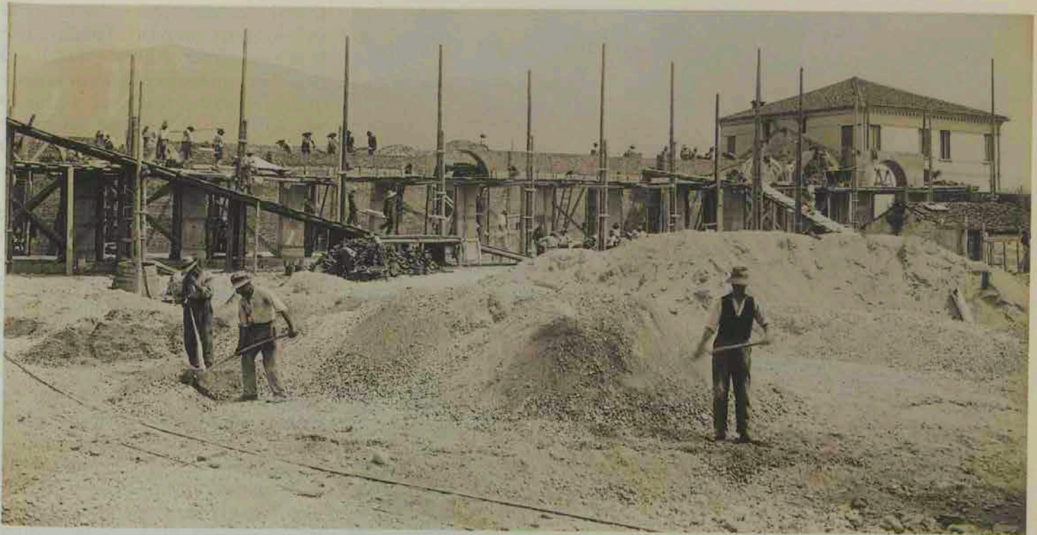
Inizio dei lavori per il Seminario Scalabrini.
