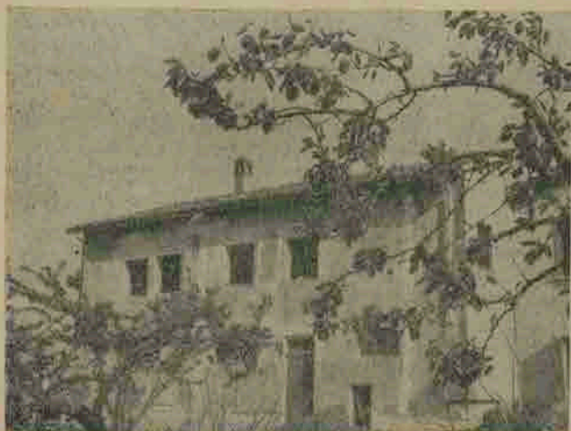
(Acilia - Roma) - Particolare della nuova Casa Generalizia delle Suore Missionarie Scalabriniane - con annesso asilo - aperta il 31 agosto 1959. E' tenuta da cinque Suore. La nuova Superiora Generale, Madre Idalina Baratter, eletta nell'ultimo capitolo il 13 Maggio u.s., in Brasile, giungerà presto a prendere possesso della nuova residenza generalizia.
