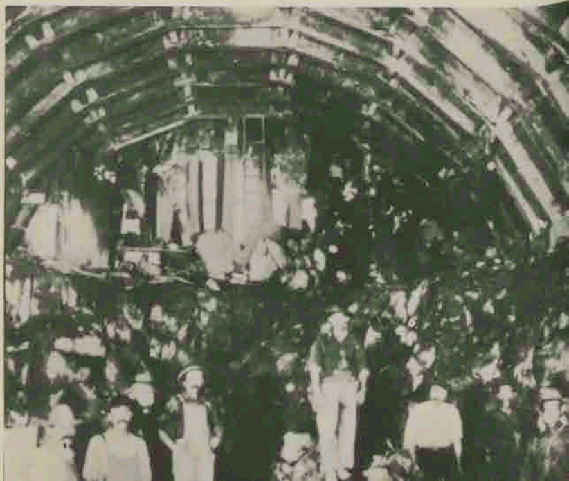
Costruzione del Fort George IRT Tunnel (N.Y. Historical Society, 1904)
