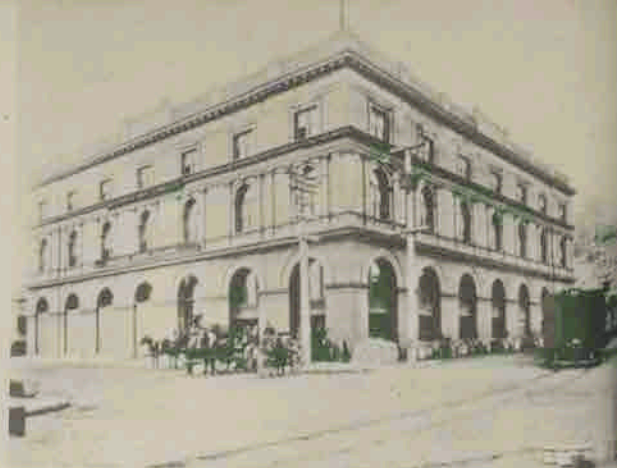
Stabilimento vinicolo della colonia di Asti (California) (fl. USA, 1906)
