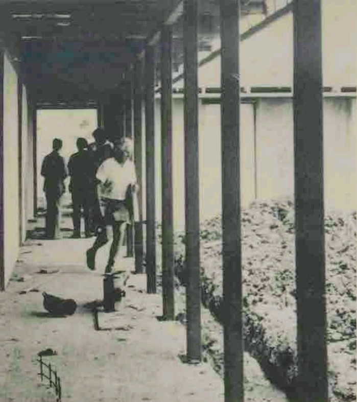
Villaggio Scalabrini: particolare dell'edificio in costruzione.
