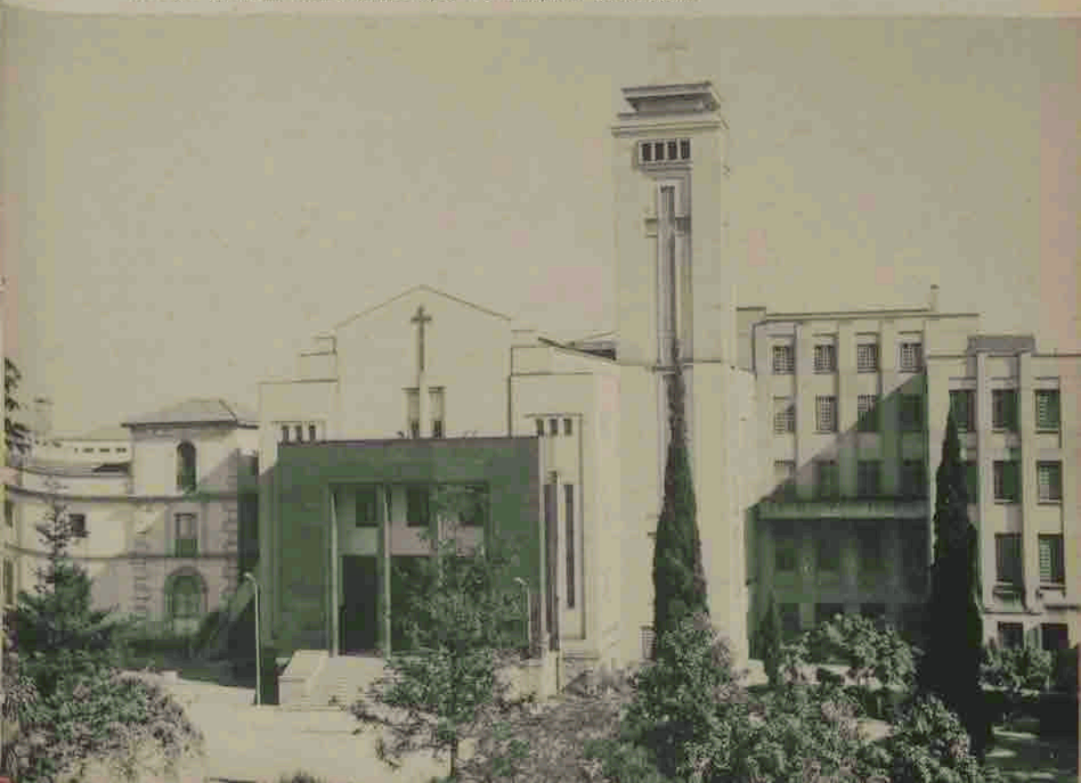
Veduta parziale dell'orfanotrofio «Cristoforo Colombo».
