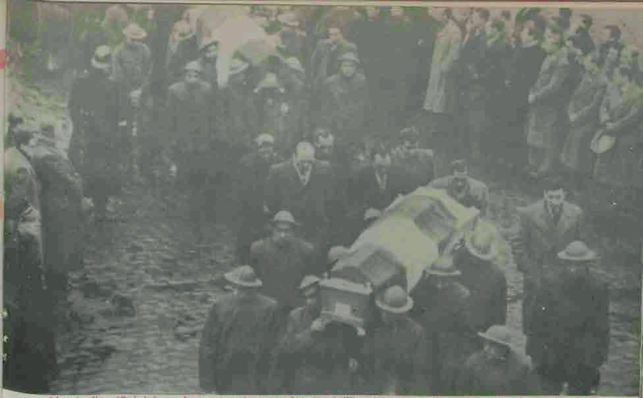
Marcinelle (Belgio). - I compagni sopravvissuti dell'immane tragedia mineraria, che nel 1956 ha sepolto 262 vittime, di cui 136 italiani, nel tristemente famoso pozzo « Bois du Cazier », accompagnano le salme dei minatori alla Cappella mortuaria.
