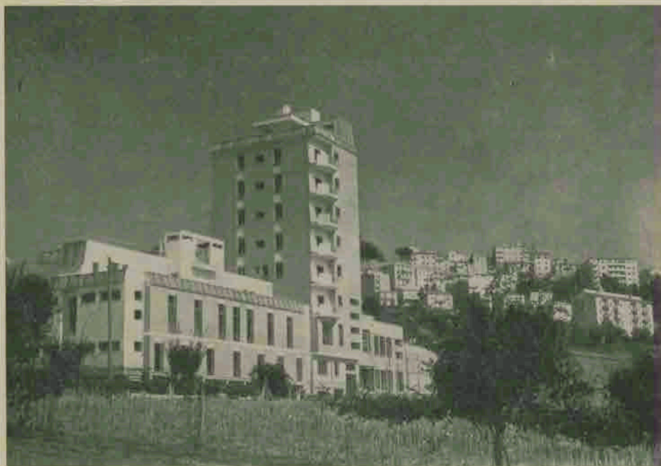
Il padiglione ultimato dell'Istituto S. Carlo di Osimo (Ancona)
