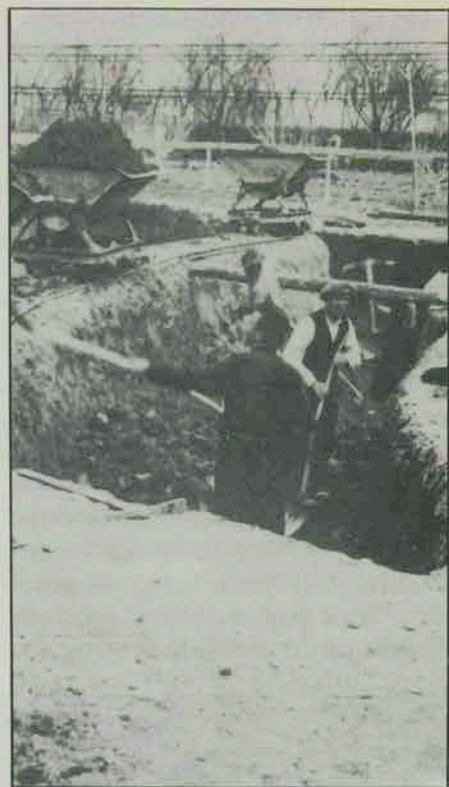
Si scavano le fondamenta della Chiesa.
