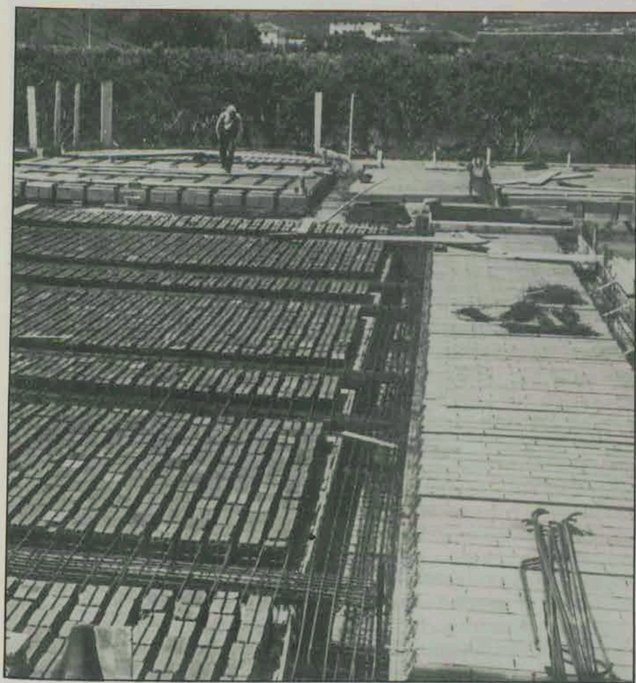
Le fondamenta della parte nord del Seminario.
