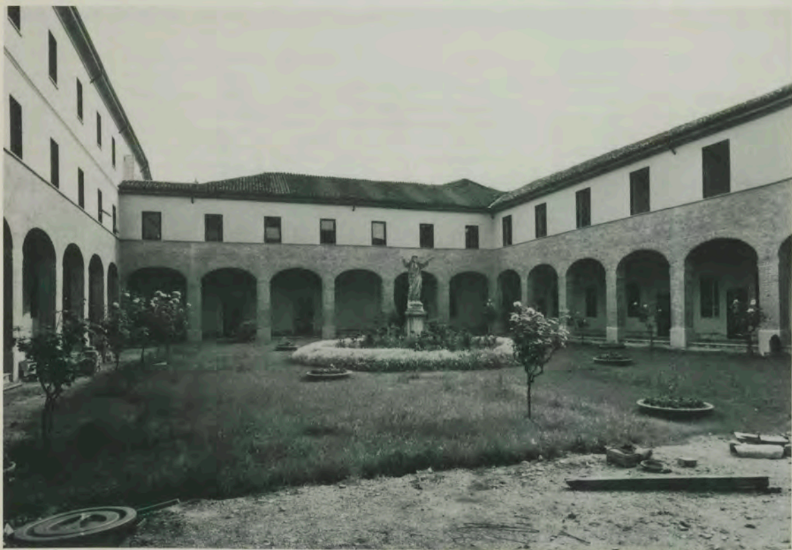
Uno dei due chiostrini durante i recenti lavori di restauro.
