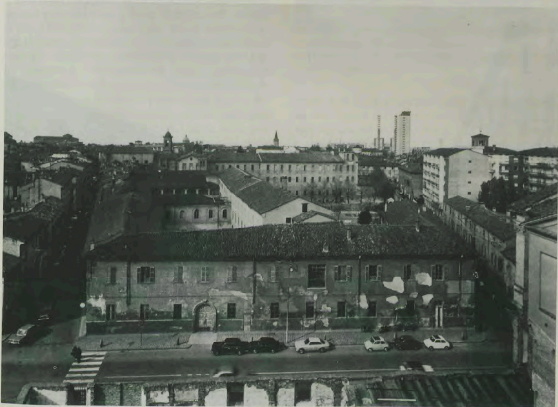
La Casa Madre, prima del restauro, tra Via Torta, Stradone Farnese e Via Caccialupo.
