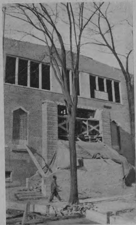
MILWAKEE - La Chiesa e la scuola di Santa Rita in costruzione
